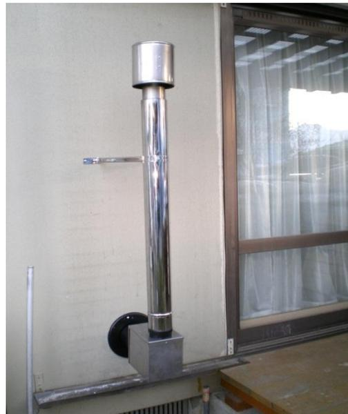
各接続部に耐熱性のゴムシーリングを取付けた後、壁の貫通穴にグラスウール製の壁内断熱筒を取付け→その中に給排気用横筒外側を入れる→横筒外側の室内側と室外側の両方にフランジをネジ止めして固定する→給排気用横筒外側の中に給排気用横筒内側を入れる→その先端をストーブ本体の排気口にしっかり奥まで差し込む。
