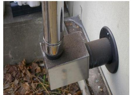
1137時間燃焼後の煙突及び周囲の汚れ具合
